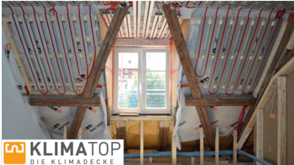
Einbau eines Decken-Heiz- und Kühlsystems von KLIMATOP
