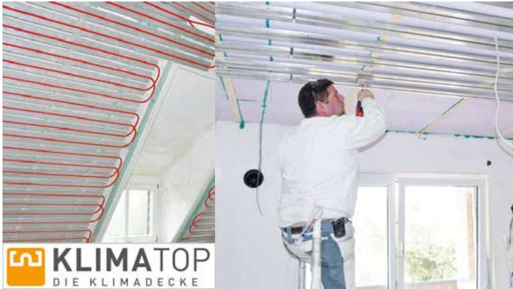
Einbau eines Decken-Heiz- und Kühlsystems von KLIMATOP
